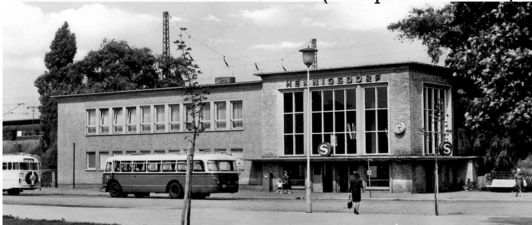
1965: Bahnhofshalle mit MITROPA-Gaststättenanbau
